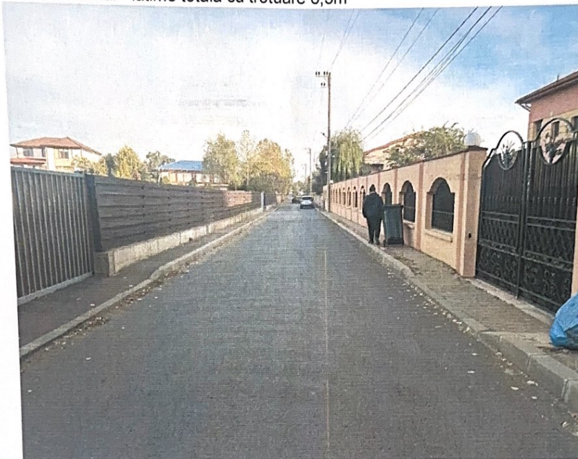
Pe zona fara trotuare latimea este de 4,5m, dar si zone cu 5,0m
